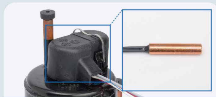
測定變頻壓縮機溫度 異常時自動停止
